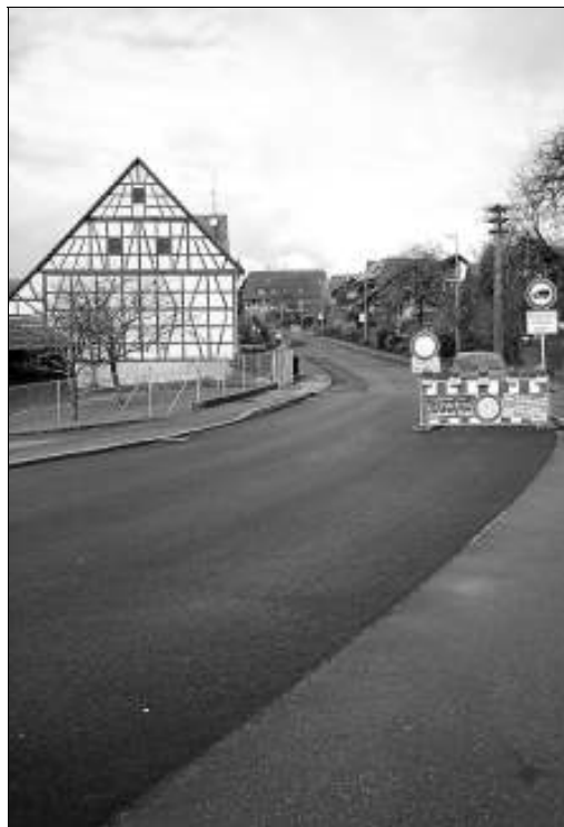
Für die Belagsarbeiten ist eine Vollsperrung der Schönbronner Ortsdurchfahrt erforderlich.
