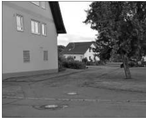
In der Breitenberger Hauswiesenstraße sollen die geplanten Straßenbauarbeiten am 15. August beginnen. Foto: Büchele
