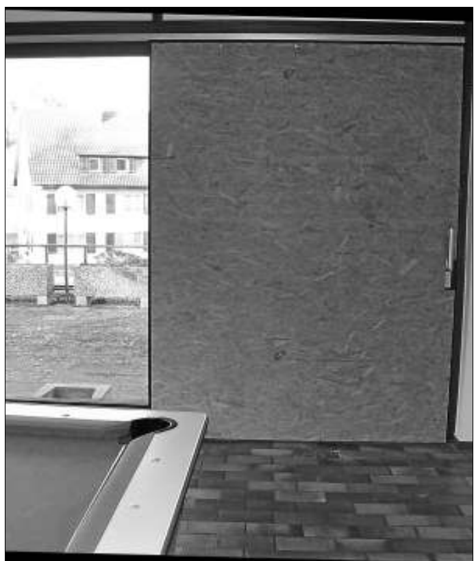
Mitarbeiter des Baubetriebshofs haben die Glastür des Jugendtreffs provisorisch repariert. Foto: Buchner
