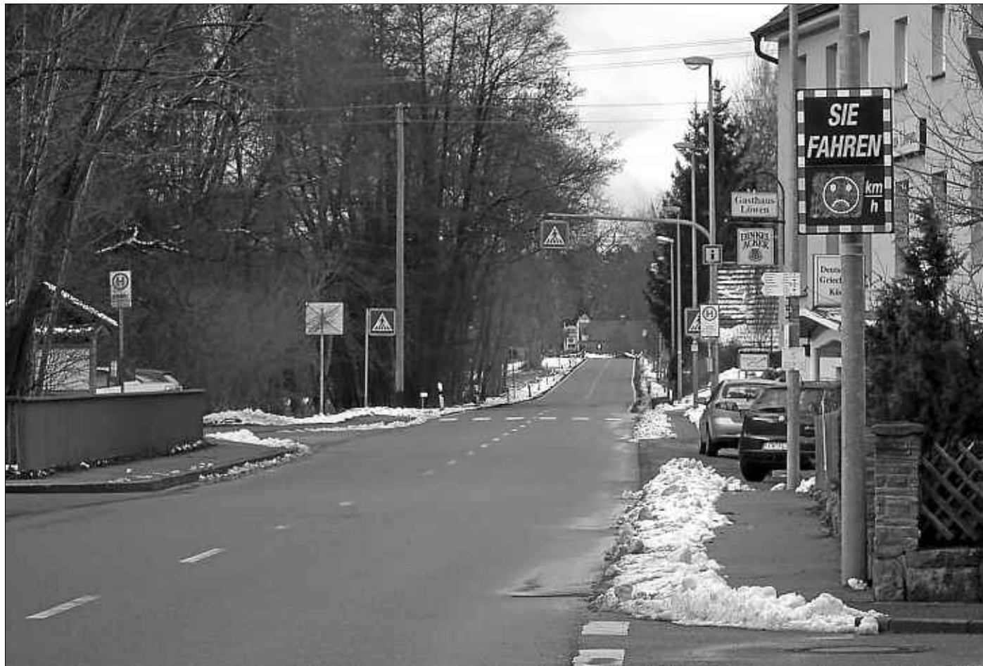
An der Durchgangsstraße von Oberreichenbach auf der B296 soll eine stationäre Messanlage installiert werden. Das Smiley-Display zeigt zu oft Rot. Foto: Stocker
