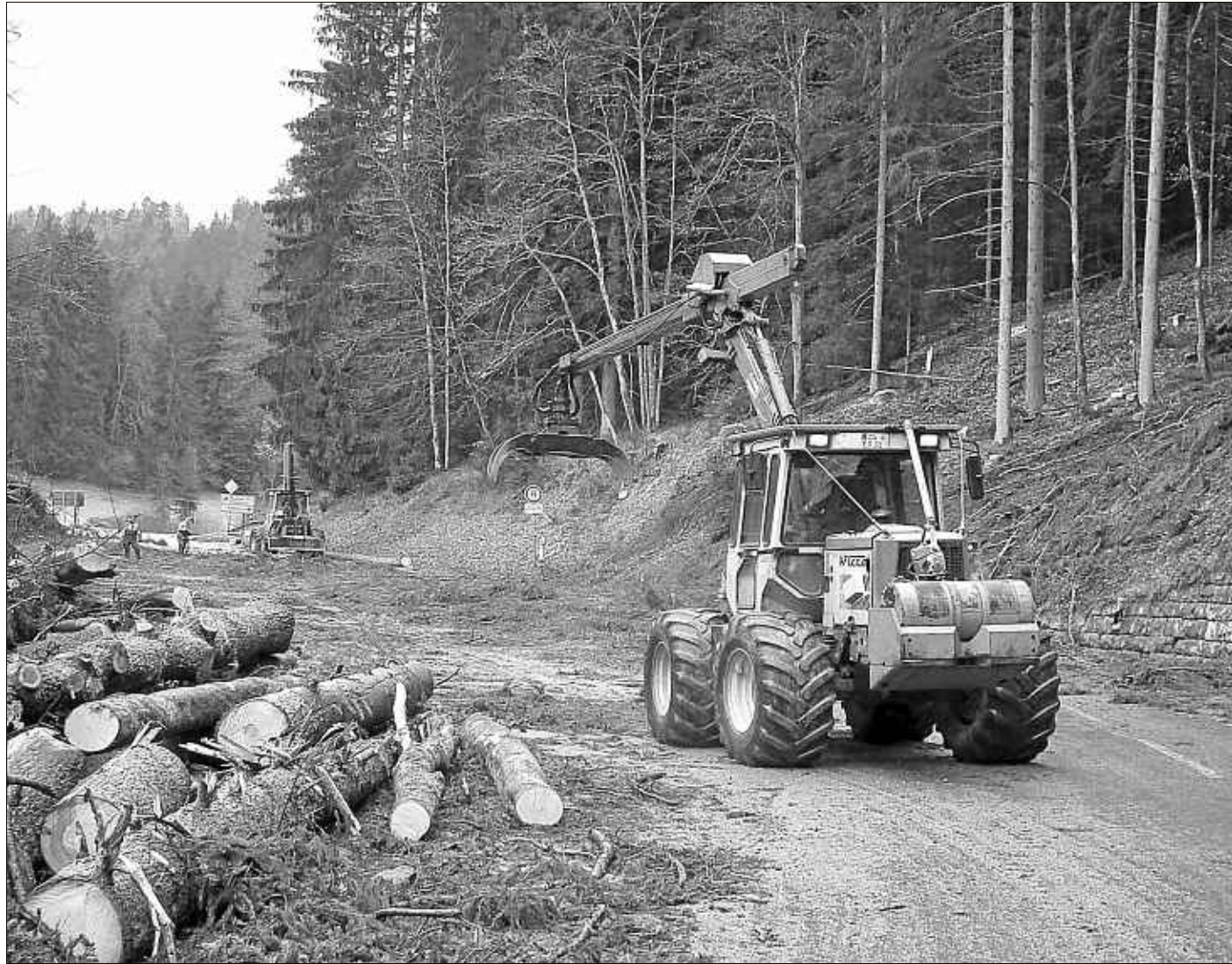
Die Rodungsarbeiten als Vorbereitung auf eine Straßenbau-Maßnahme entlang der Landesstraße bringen die Sperrung eines Teilstücks der L 347 zwischen Bad Teinach und Oberkollwangen mit sich. Foto: Stocker
