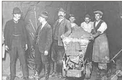
Mühsam ist der Bau des zwei Kilometer langen Stollens gewesen.
