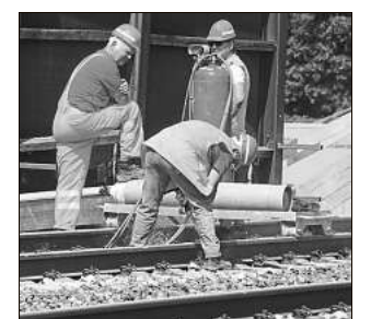
Arbeiten an der Rheintal-Bahntrasse Foto: Deck
