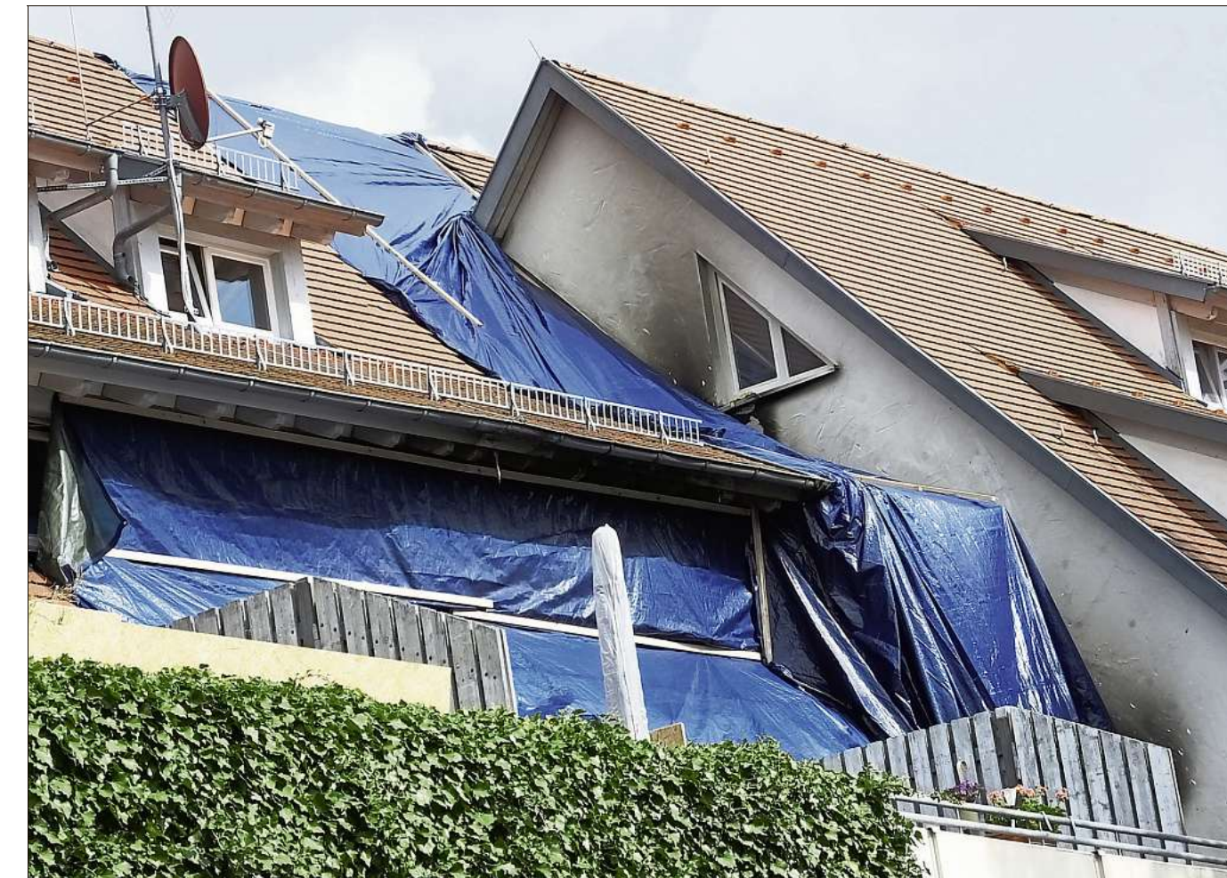
Mit Planen wurde das Dach an dem vom Feuer betroffenen Gebäude abgedeckt.
